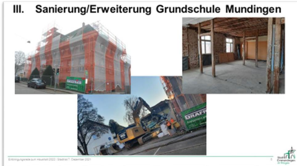
Mitte 2021 hat der 2. Bauabschnitt mit der Sanierung des Altbaus der Mundingener Grundschule begonnen. Die ersten Maßnahmen beinhalteten die Entkernung des Gebäudes und den Rückbau bis auf den Rohbauzustand.
